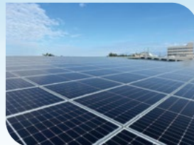
▲ 工場エリアでの太陽光発電システムの設置
